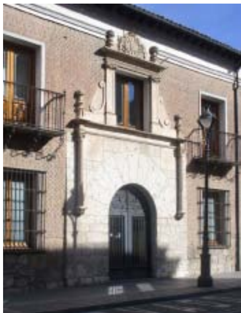
Portada de la casa de los Astete colocada en el edificio de la Diputación Provincial.
